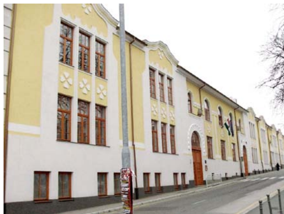
Az épület a bővítés után
