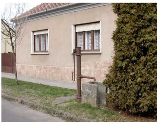
A város belső része egyetlen megmaradt közkútjának öntöttvas vízemelő szerkezete a 61. számú ház előtt (Miklósfa városrészben található még néhány hasonló darab.)
