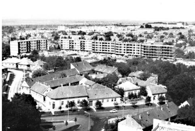
A tér keleti oldala és a Petőfi utca eleje korábban: Huszti tér 6., 7., 8. (sarokház) és Petőfi utca 2. (szomszéd jobbra) (TGYM)
