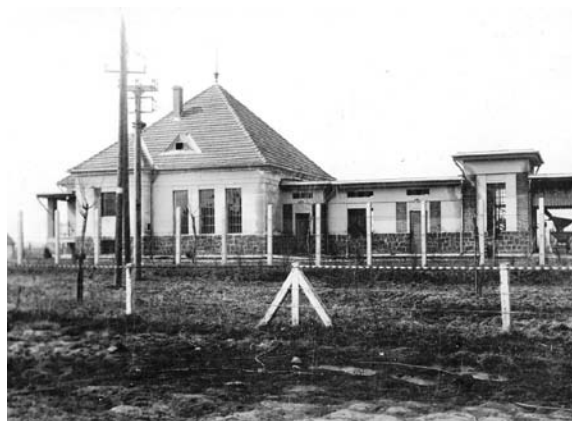
Az épület északi oldala
