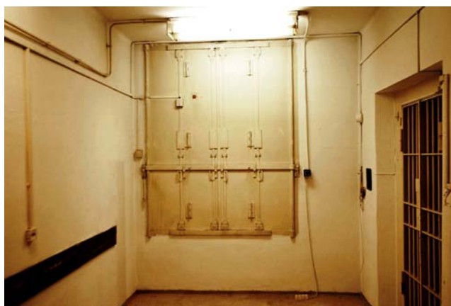
A pénztár ablaknyílásának fedésére szolgáló ablaktáblák (Munkaidőn túl a földszinti helyiség ablakát ezekkel zárták le. Anyaguk nem fa, hanem acél.)
