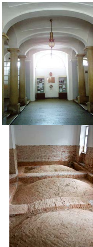
A pince boltozata egy földszinti teremben a 2010-es felújításkor
