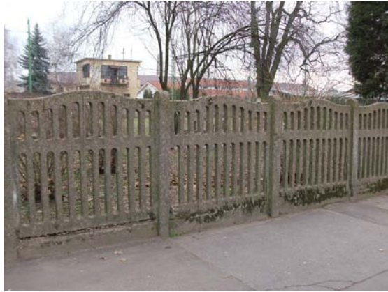
Betonból öntött kerítés az épület déli oldalán
