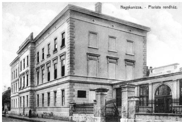
Az utcai épület az átépítés után
